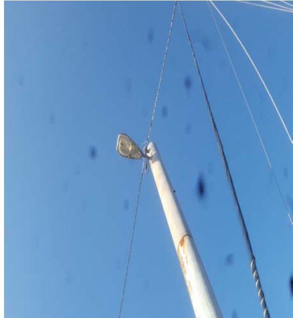
Steel piling mount.
