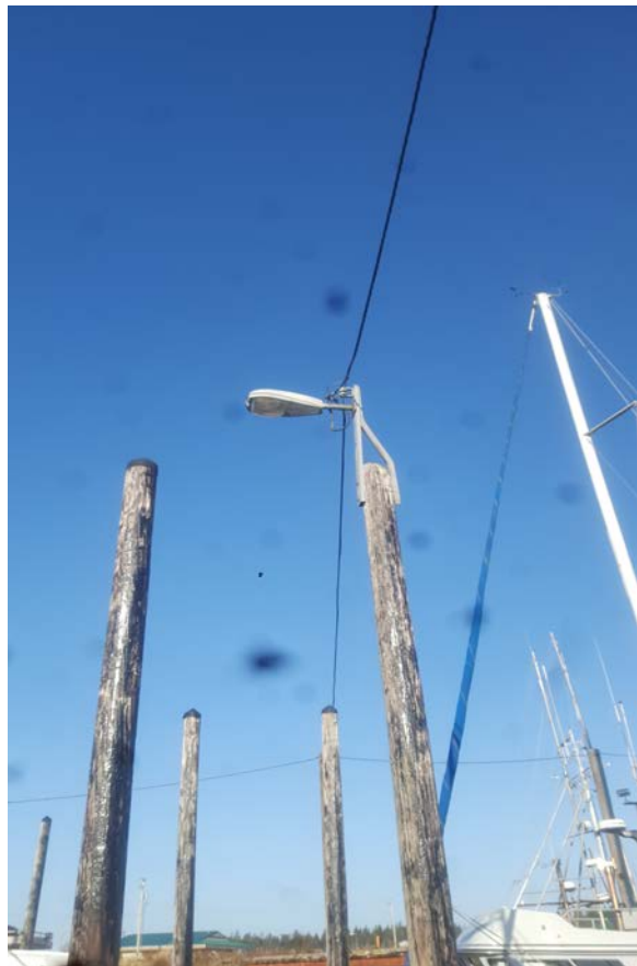
Wood piling mount.
